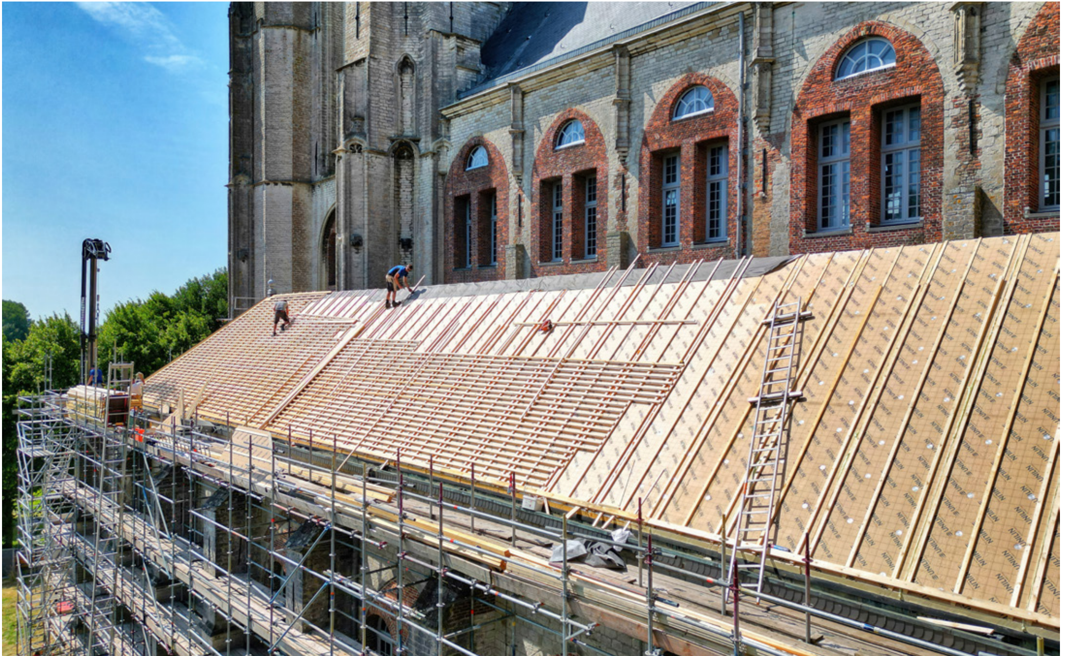
Onderhoudswerkzaamheden Grote Kerk te Veere
