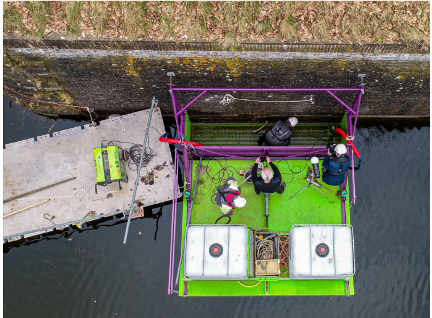
Onderhoudswerkzaamheden Vestingwerken te Naarden
