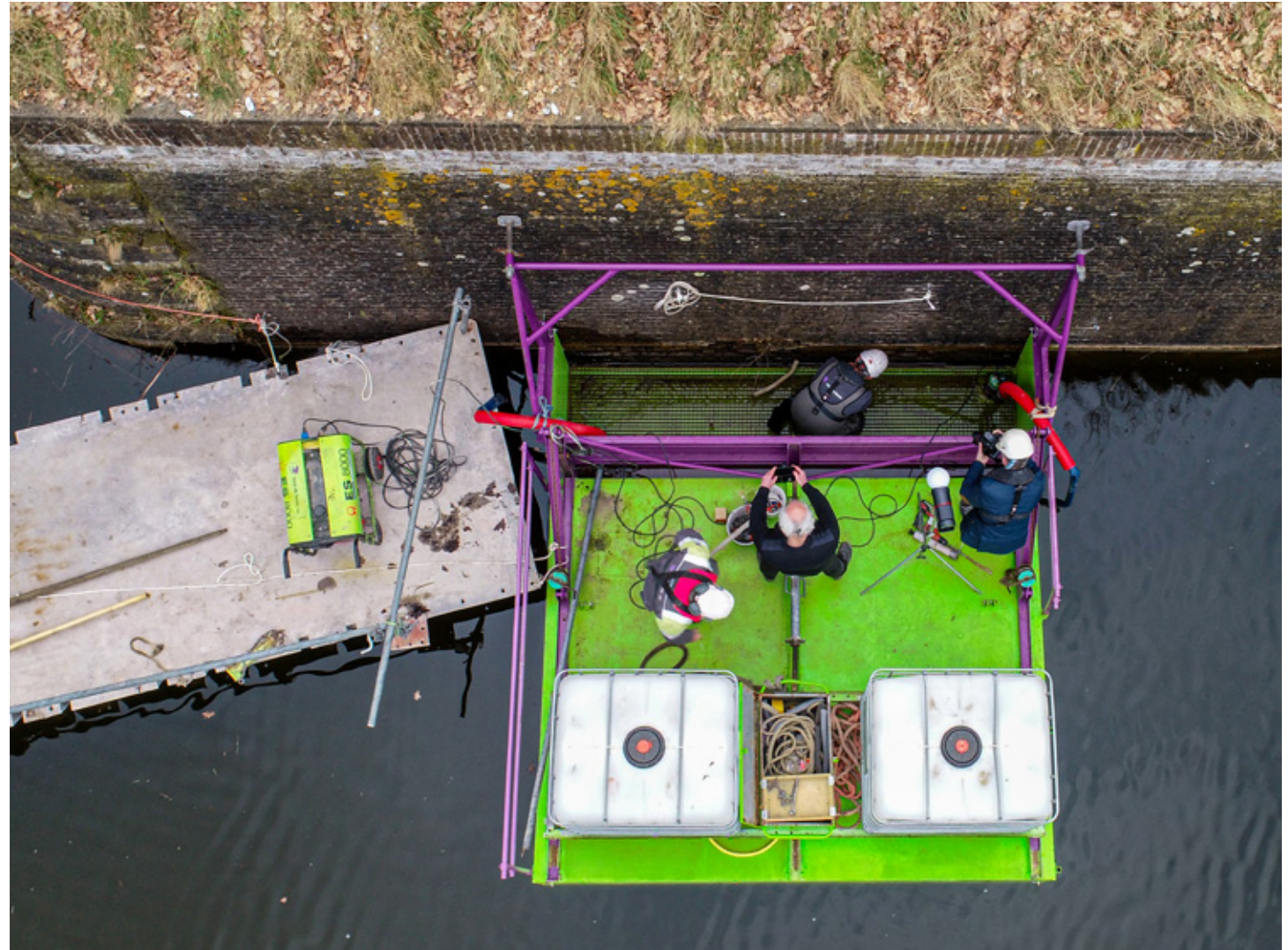
Onderhoudswerkzaamheden Vestingwerken te Naarden
