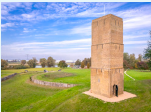
Stenen Baak, Oostvoorne Metsel- en voegwerkherstel aan de gevels
