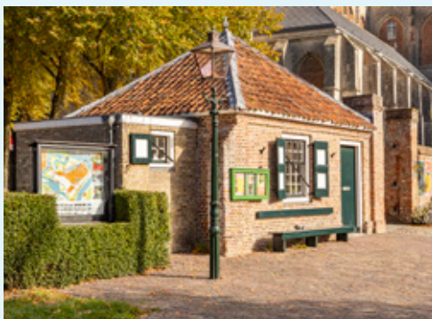
Voormalig Poortwachtershuisje, Veere Geen bijzondere werkzaamheden.
