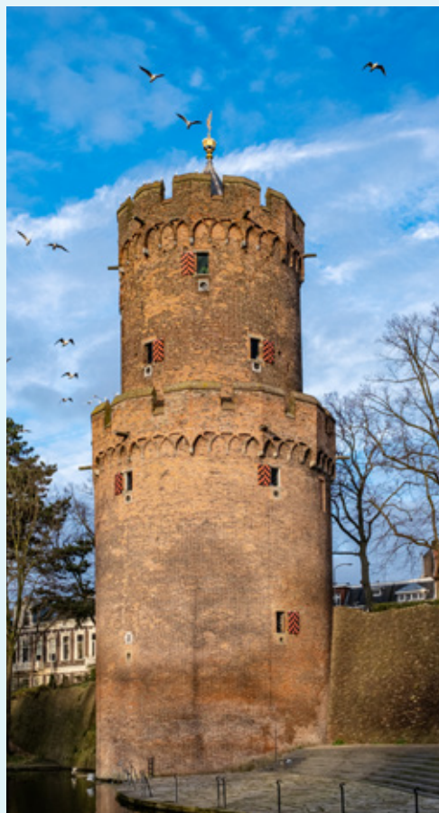
Kronenburgertoren, Nijmegen Geen bijzondere werkzaamheden.
