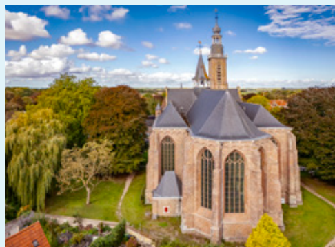
Sint-Baafskerk, Aardenburg Geen bijzondere werkzaamheden.
