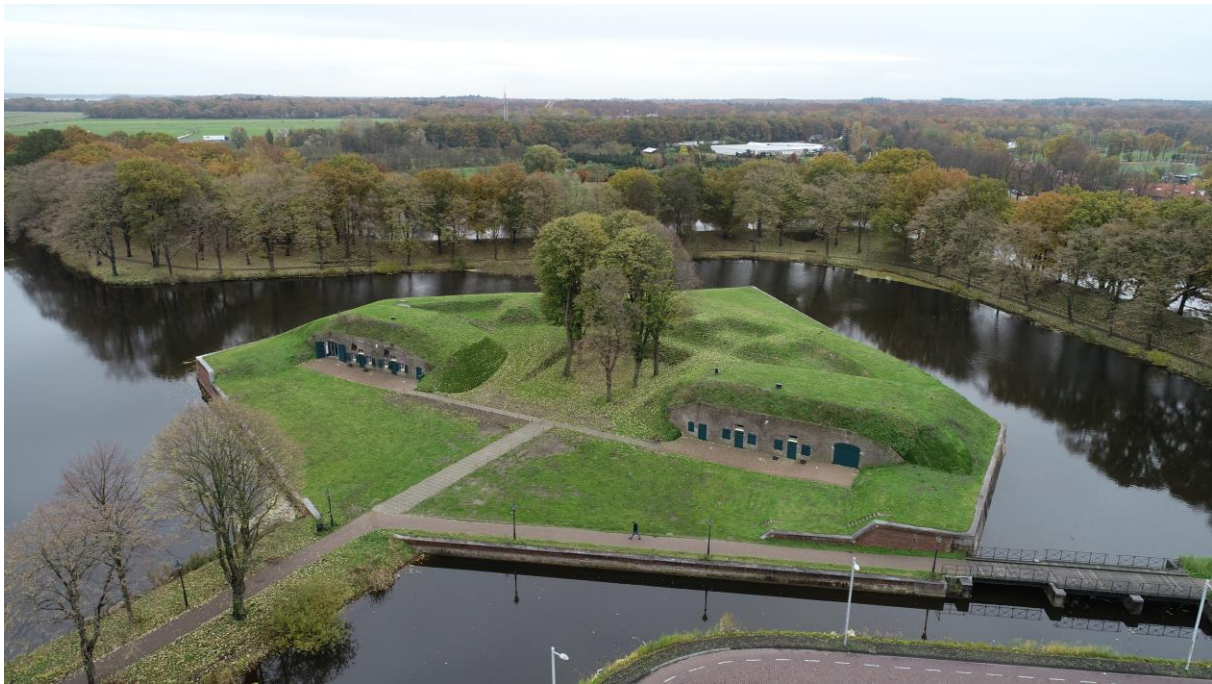
Afb. 12 Twee bomvrije gebouwen op het ravelijn voor de Utrechtse Poort in Naarden. Ze werden aangelegd in 1875. (Stichting Monumentenbezit, 2019)
