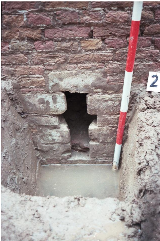
Afb. 9 Een van de vier schietgaten onder in de toren in de wal. Collectie Werkgroep Loevesteyn.
