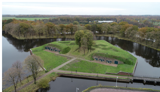
2) Twee bomvrije gebouwen op ravelijn 6 in Naarden. Ze werden in 1875 gebouwd. (foto Monumentenbezit)
