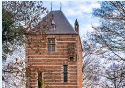
Kasteeltoren, IJsselstein Geen bijzondere werkzaamheden.
