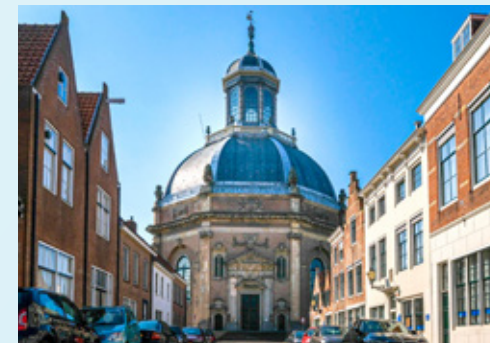
De Oostkerk, Middelburg Schilderwerk klokkentoren en balustrade, natuursteen herstel obelisk en entreetrap.
