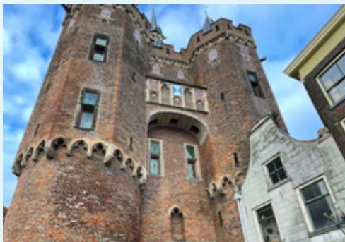
Sassenpoort, Zwolle Geen bijzondere werkzaamheden.
