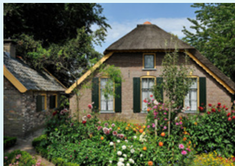
Mariahoeve, Hazerswoude Schilderwerk/ houtrotherstel
