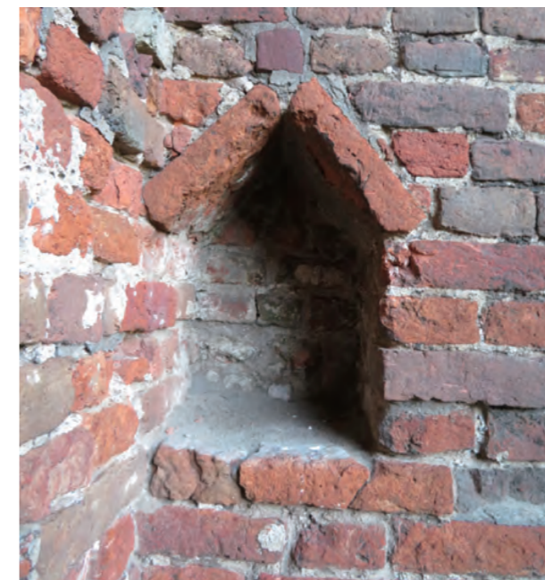
그림 143. 테일링언 아성(keep, 牙城)의 내부에 13세기 중세 벽돌 모습. 성벽은 성의 오랜 건축 역사의 흔적을 보여준다. Fig. 143. View of the inside of the keep of Teylingen. Medieval bricks (13 th century). The walls show the traces of the long building history of the castle.
