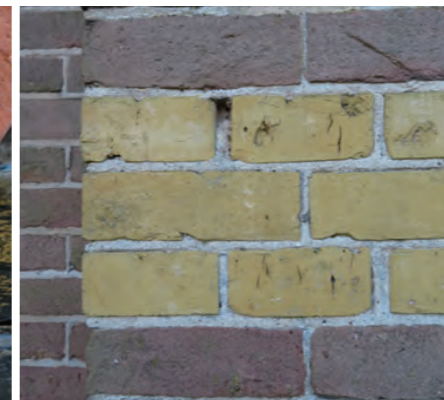
그림 173. 나르덴 요새 내 프로메어스 보루 막사의 다른 벽돌 구조. 보라색 벽돌은 빈약한 점토로 만들어졌으며 벽돌 표면에 거푸집의 모래가 그대로 남아 있다. 노란색 돌은 비옥한 점토로 만들어져 보라색 벽돌보다 훨씬 밀도가 높고 매끈하다. Fig. 173. Naarden, the barracks of the Promers bastion. Different structures of bricks. The purple bricks were made of a meagre clay. The sand of the mould is still visible on the surface of the bricks. The yellow stones were made of a rich clay. They are much denser and smoother than the purple bricks.
