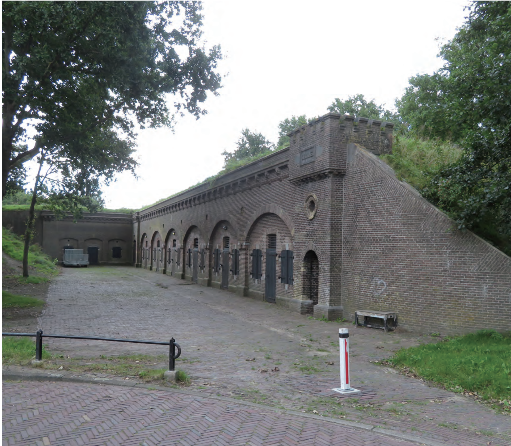
그림 175. 2020년에 복원된 막사의 외관. Fig. 175. The façade of the barracks that was restored in 2020.
