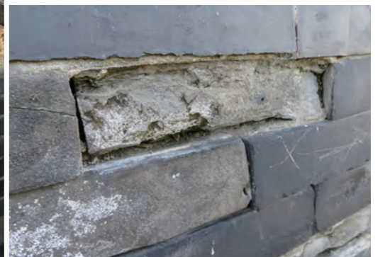
그림 207. 그림 206의 벽돌 세부 모습. 벽돌 표면은 광택제 같은 마감 처리가 된 것 같다. 이는 조적조의 물 운반에 영향을 미치나? Fig. 207. Detail of one of the bricks of figure 206. Here the outer layer of the brick seems to have an extra finishing, like a glazing. How does this influence the water transport through the masonry?
