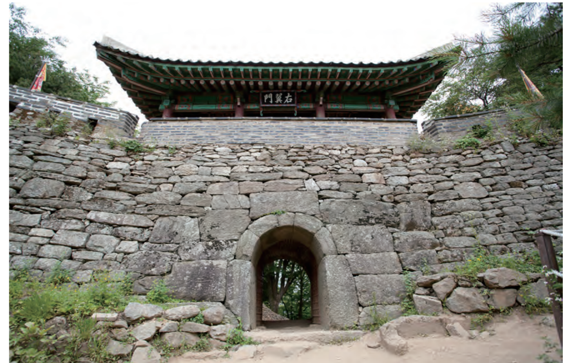
그림 185. 벽돌 여장이 있는 남한산성 서문 Fig. 185. The Seomun Gate of the Namhansanseong Fortress, with a brick parapet.
