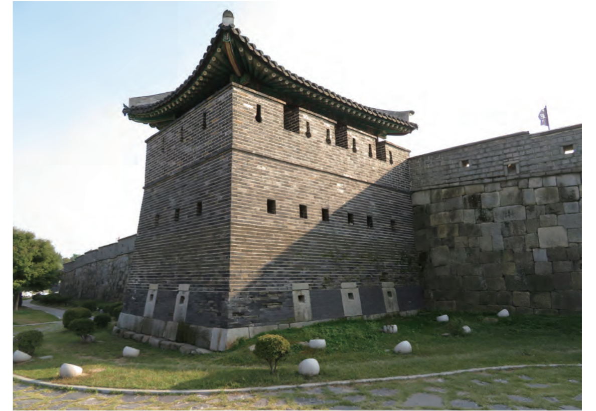
그림 200. 화성의 포루 중 하나로 벽돌과 줄눈의 세 가지 다른 무늬가 있다. 아래의 기반부는 줄눈이 매우 얇아서 거의 보이지 않고, 그 위의 포루의 몸통 부분은 수평 줄눈만 보인다. 윗부분(여장)은 일반적인 줄눈으로 된 벽돌 구조를 확인할 수 있다. Fig. 200. One of the towers of the Hwaseong Fortress. It shows three different patterns of bricks and joints. In the bottom part, the joints are very thin and almost invisible. The large part above it only shows the horizontal joints. The top part (the parapet) shows masonry with regular joints.
