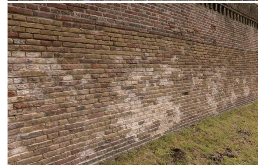
그림 165. 줄눈을 제거하면서 벽돌에 금이 간 부분도 모두 제거하였다. Fig. 165. With the removal of the joints, all the cracked parts of the bricks were removed as well.
