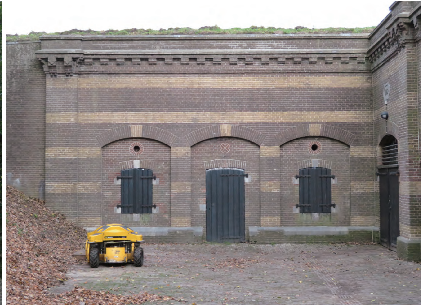
그림 176. 외관에 쓰인 벽돌의 다양한 종류와 색상을 보여주는 세부 모습. Fig. 176. Detail showing the different types and colours of bricks in this façade.
