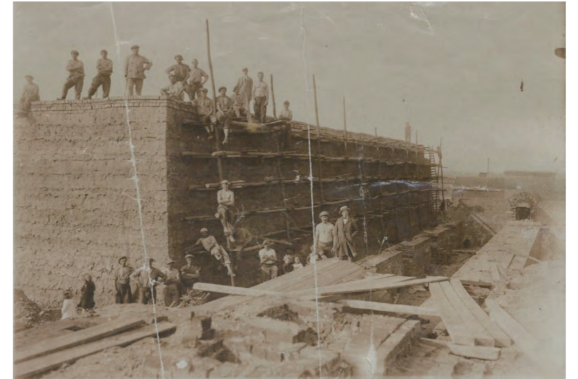
그림 141. 노천 가마 사진. 가마에서 생산할 수 있는 엄청난 양의 벽돌을 보여준다. (1920년 경) Fig. 141. Photo of a field-oven around 1920. It shows the gigantic quantity of bricks that could be produced in such an oven.
