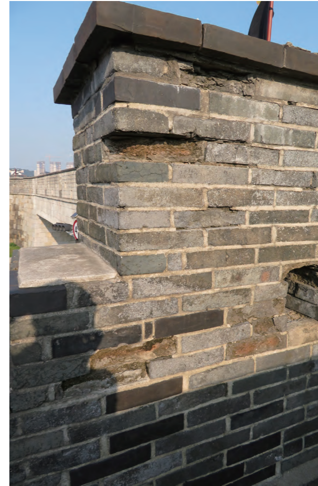
그림 205. 화성 장안문 여장의 조적조. 벽돌 중심은 붉은 색을 띠며 경·밀도에 차이가 있는 것 같다. 이 차이가 관찰한 손상 원인 중 하나로 추정된다. Fig. 205. The masonry of the parapet of the Janganan Gate of the Hwaseong Fortress. Some of the bricks show a reddish core. Furthermore, there seems to be a difference in hardness and density of the bricks. This might be part of the reason of the damage that I visible.
