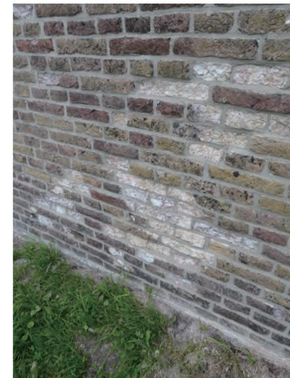
그림 166 새로운 줄눈의 세부 모습으로, 벽돌의 불규칙한 표면을 따라 줄눈을 시공했다. Fig. 166. Detail of the new joints. They were put in, in such a way that the joints follow the irregular surface of the bricks.
