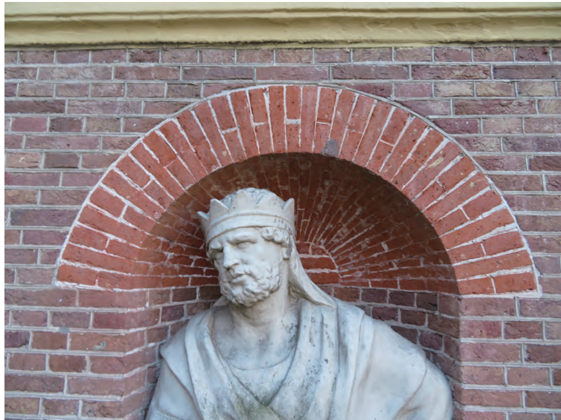
그림 171. 흐라블란트(Graveland)의 트롬펜뷰아흐(Trompenburgh) 성. 벽돌과 줄눈 간 상호작용. 주황색 벽돌은 매끈하게 보이도록 연마되어 주변의 보라색 벽돌보다 돋보인다. Fig. 171. Trompenburgh palace in 's Graveland. The interplay between bricks and joints. The orange bricks are polished to make them look smooth and stand out from the surrounding purple masonry.
