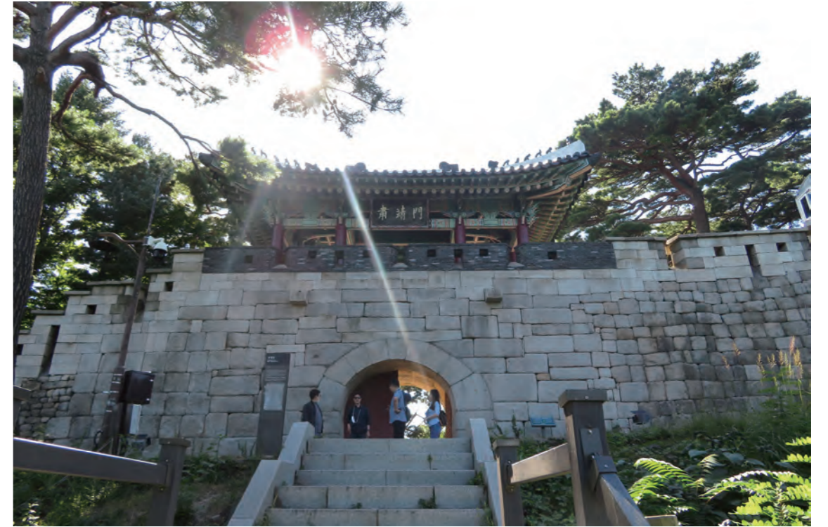
그림 184. 숙정문은 성벽의 화강암 여장이 문루에 벽돌 여장으로 대체된 것이 흥미롭다. Fig. 184. The Sukjeongmun Gate. Here it is interesting to see that the granite parapet of the wall is replaced by a brick one at the pavilion of the gate.
