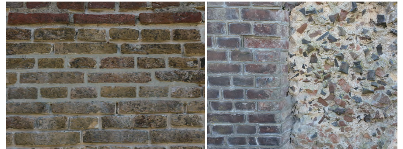
그림 146. 당시의 벽돌이 더 작고 모두 비슷한 모양과 크기를 가지고 있음을 명확하게 보여주는 조적조의 세부 모습. 테일링언의 벽돌보다 훨씬 더 일정한 방식으로 벽돌이 결합되어 있다. 수세기에 걸쳐 생산 방식이 어떻게 발전했는지 보여준다. Fig. 146. Detail of that masonry, clearly showing the bricks of that period are smaller and all have a similar shape and size. Making the brick bonding much more regular than that of Teylingen. It shows how production methods have improved over the centuries.
