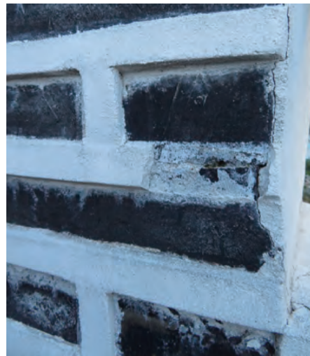
그림 191. 실제 줄눈의 간격은 얇지만 벽돌 위에 모르타르를 덧칠하여 줄눈을 더 넓게 보이게 하는 것을 보여준다. Fig. 191. This detail of the joints shows that the actual joint is thin, but the mortar is smeared over the brick to make the joint look wider.
