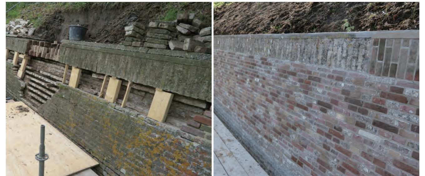
그림 152. 복원 작업 중인 성벽 Fig. 152. The wall during restoration work.
