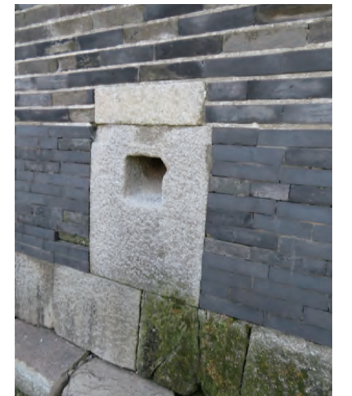
그림 201. 포루의 기반부 세부 모습으로 두 가지 유형의 조적 구조를 볼 수 있다. Fig. 201. Detail of the bottom part of the tower. Showing two types of masonry.
