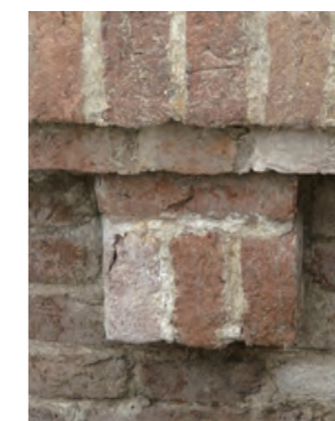
그림 168. 발굴된 원형 벽의 일부(1680년 경). 벽의 위쪽은 훨씬 더 정교한 디테일이 있었다. Fig. 168. The excavated part of the original wall (ca. 1680). The top of the wall used to have a much more sophisticated detailing.
