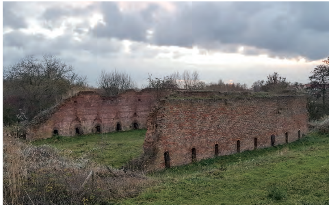
그림 137. 영구 노천 가마의 벽체. 건조된 벽돌을 가마의 두 벽 사이에 적재한다. 벽 아래쪽의 개구부는 벽돌을 굽기 위해 불을 넣는 화구이다. (1872년 경)
