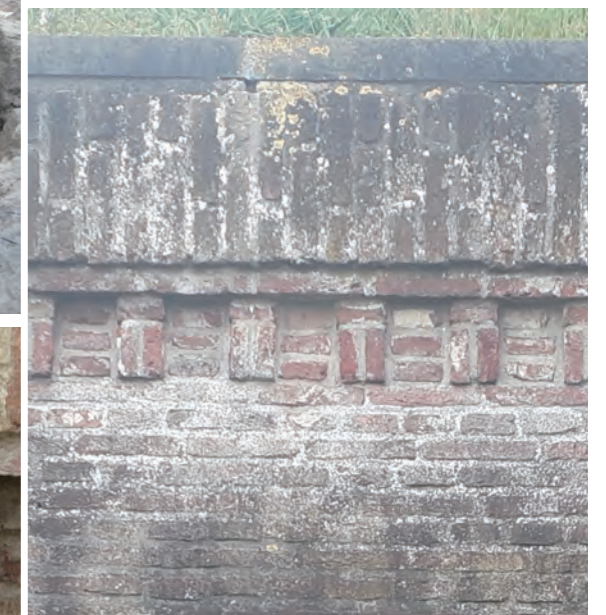
그림 170. 오늘날 성벽의 위부분 디테일로 원형의 벽보다 덜 정교하다. Fig. 170. The detailing of the top part of the wall today. It is less subtle than the original one.
