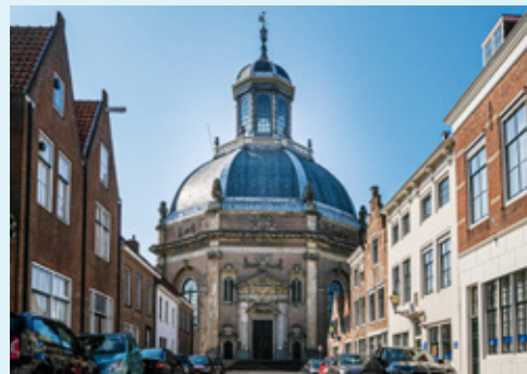
De Oostkerk, Middelburg Schilderwerk klokkentoren.
