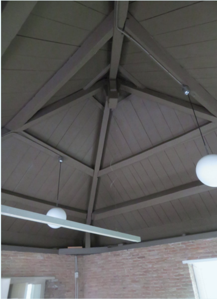
33 De kapconstructie uit de 19 e eeuw.
