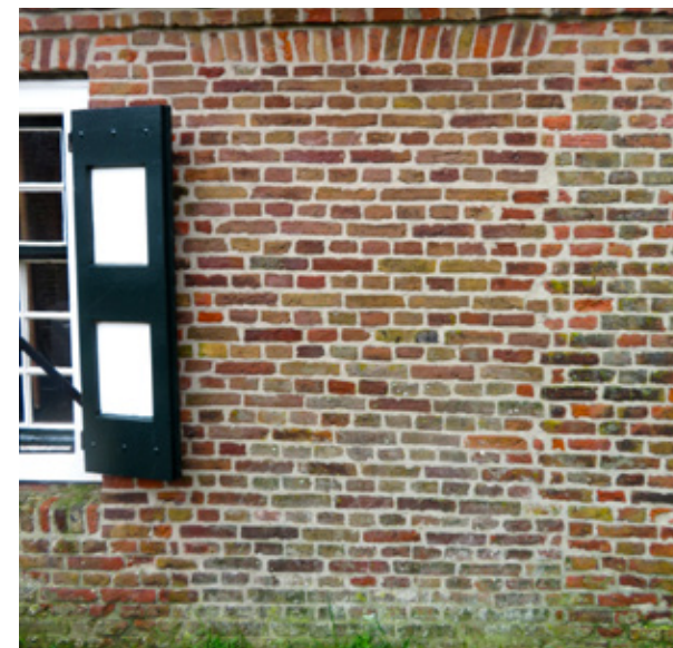
32 Detail van de dichtgemetselde deuropening in de zijgevel. De dagmaat van deze opening komt overeen met die in de voorgevel. Waarschijnlijk is het bestaande kozijn hergebruikt in de voorgevel.
