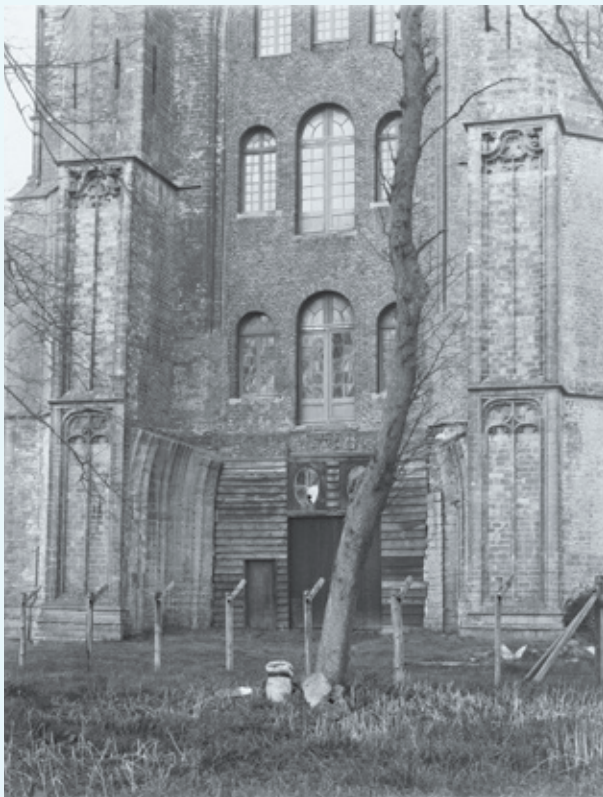
14 Zicht op de entree van de kerk rond 1952. De entree is dichtgezet met een houten gevel. Interessant detail zijn de ovale ramen die uit de hoger gelegen gevels zijn gehaald en hier hergebruikt. Het terrein direct voor de entree is afgezet met houten palen en prikkeldraad. Het illustreert de onvriendelijkheid en ontoegankelijkheid van het terrein in die eerste decennia van de 20 e eeuw.
