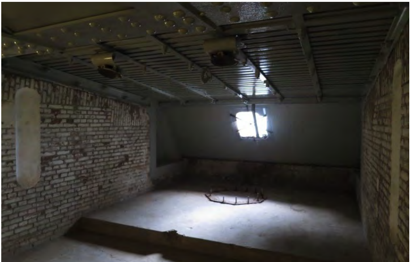
Afb. 24: Het interieur van de kazematten op fort Pannerden geeft een idee van de kazematten zoals die voorzien waren op ravelijn 5 (foto auteur)
