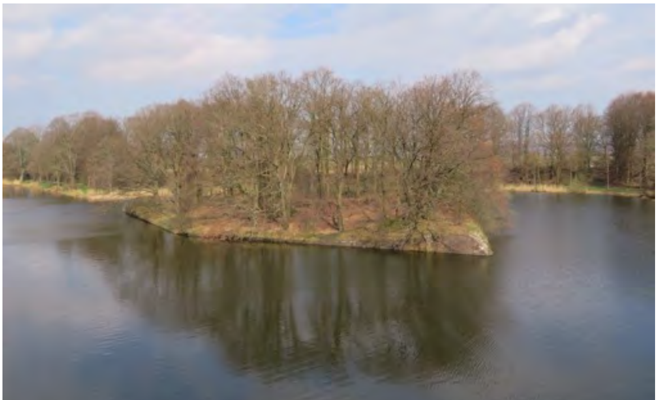
Afb. 21: De huidige situatie van ravelijn 5. Er zijn in de negentiende eeuw nooit gebouwen op dit ravelijn aangelegd (foto auteur)
