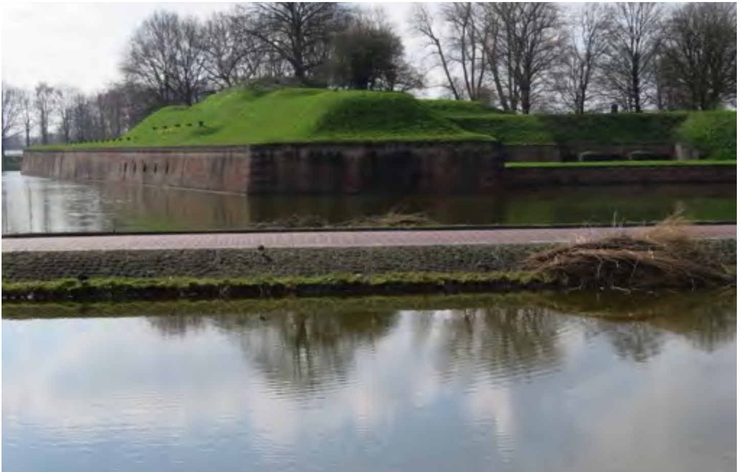
Afb. 22: De huidige situatie van bastion Promers gezien vanaf de weg naar de Utrechtse Poort. Uiteindelijk zijn alleen in de linkerflank kazematten aangelegd (foto auteur)
