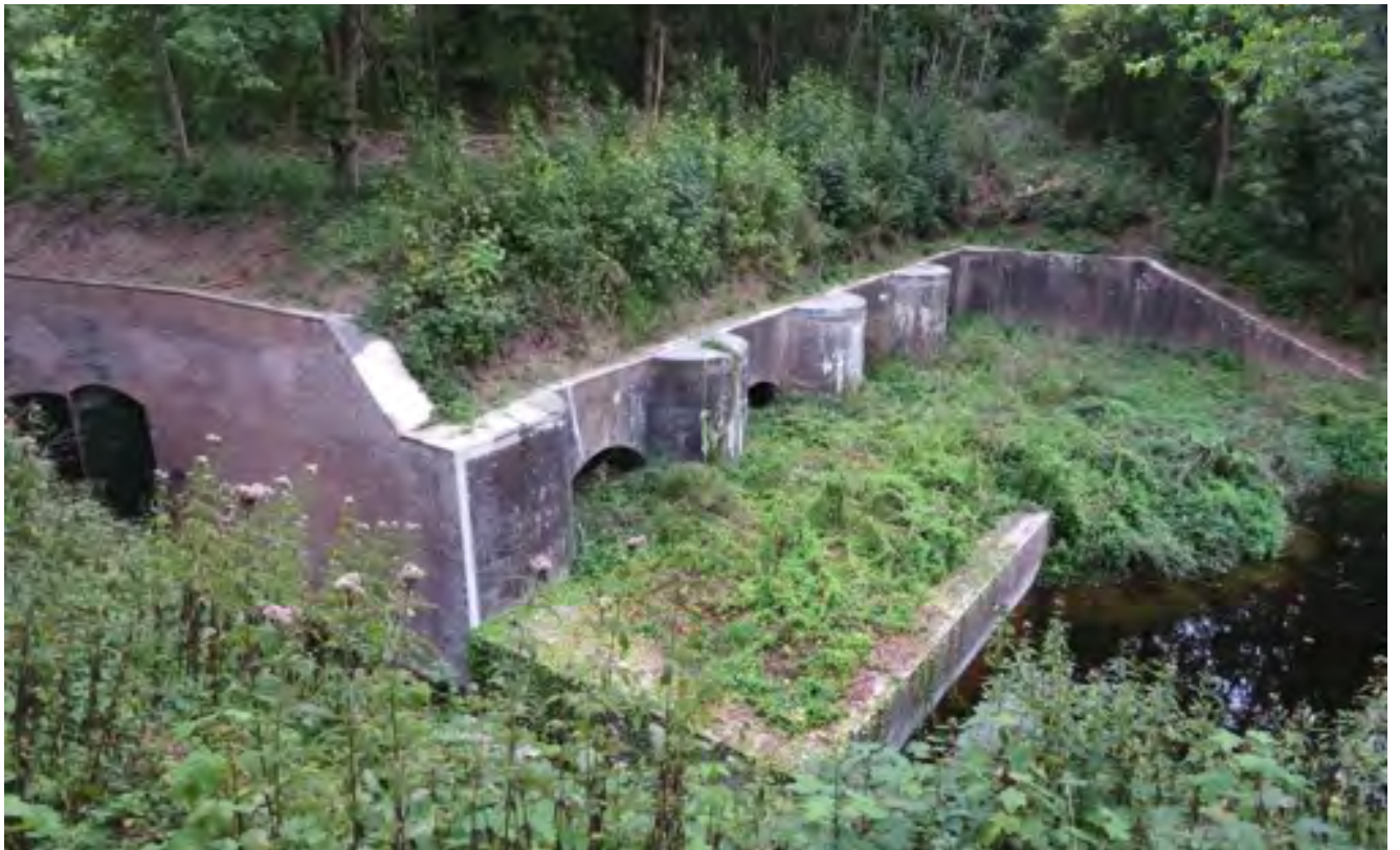
Afb. 8: De frontcaponnière van fort Rijnauwen. De kazematten worden door een vleugelmuur beschermd tegen direct vuur uit het veld. De caponnière zelf is met een gracht afgescheiden van de rest van het fort (foto auteur)
