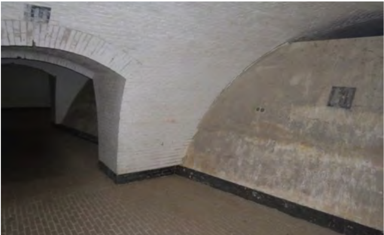
Afb. 11: Fort Rijnauwen: het interieur van de kazematten met de schuingeplaatste, betonnen achterwand (foto auteur)
