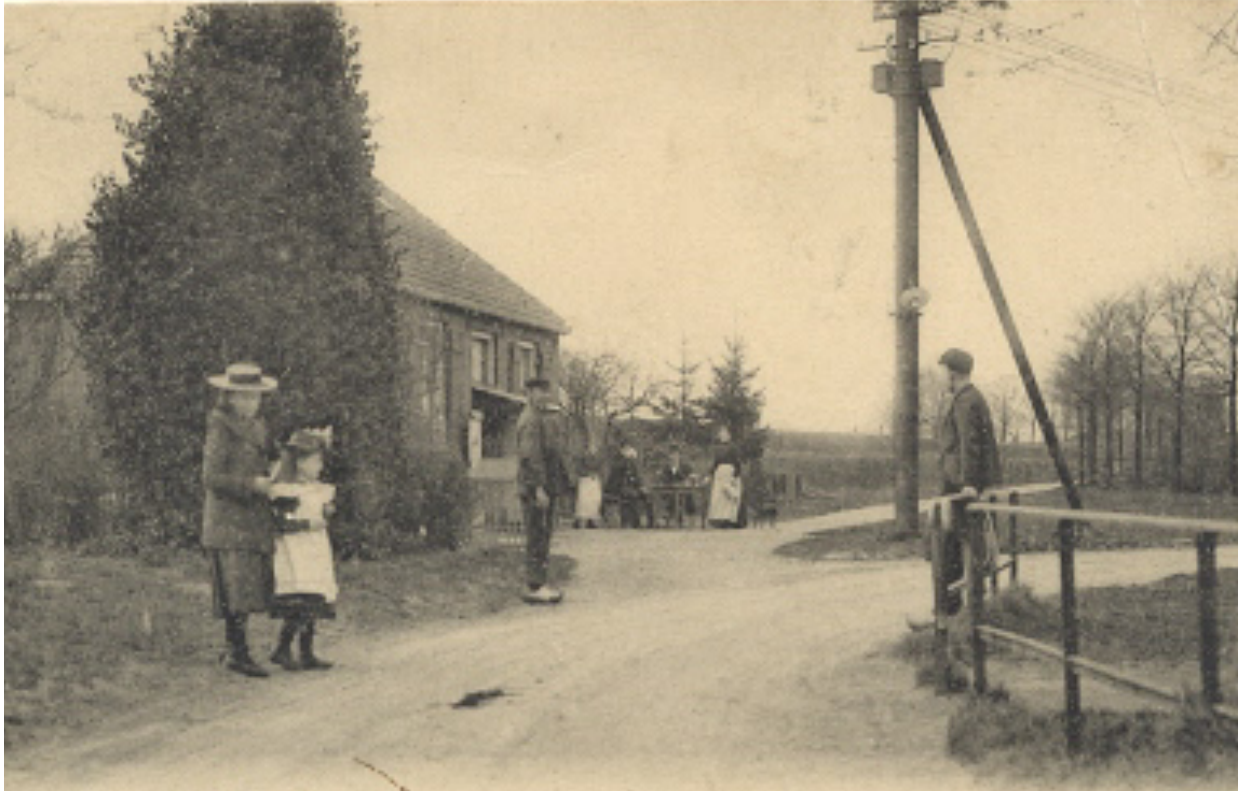
Afb. 19: brugwachterswoning BW gezien vanaf de brugzijde met het uitgebouwde privaat, 1902.
