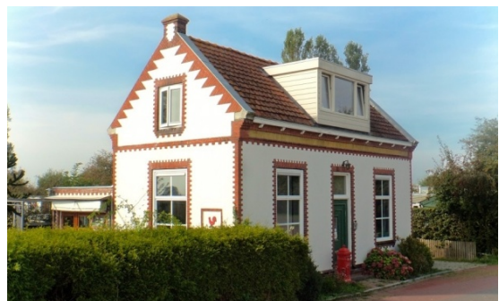
Afb. 2: brugwachterswoning Roodehaan in Groningen uit 1906.
