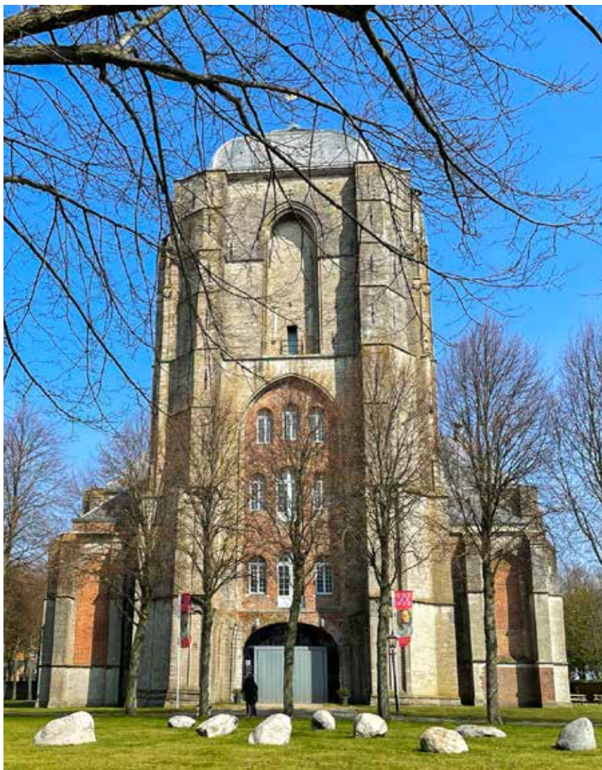
Afb. 13: de voorgevel van de Grote Kerk. Ook hier is een groot baksteenvlak ingezet met nieuwe ramen op de verdiepingen.
