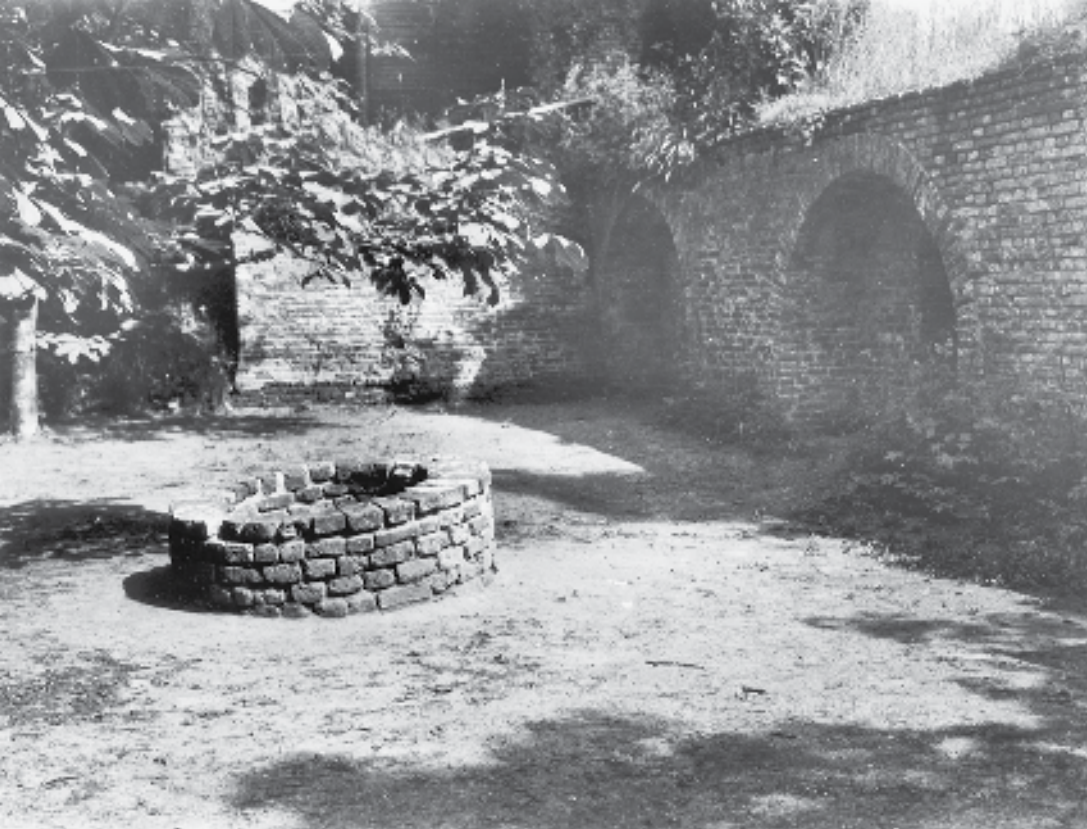
Afb. 20: foto uit 1930 van de binnenplaats van kasteel Brederode waarop de scheefgezakte waterput te zien is. Bron: Rijksdienst voor het Cultureel Erfgoed, Amersfoort /179.223.
