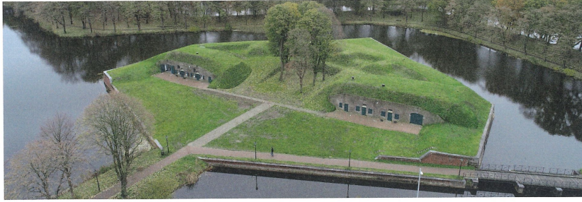
Luchtfoto van Ravelijn 6. Ook hier wilde men geschutopstellingen maken in kazematten. Uiteindelijk werden het opstelplaatsen in de buitenlucht, met daarbij een tweetal bomvrije verblijven die ook dienstdeden als wachthuizen. Stichting Monumentenbezit, 's-Graveland.
