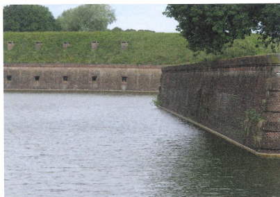
Zicht langs het front van een van de ravelijnen op de kazematten in het front van het daarachterliggende bastion. Hierop is goed te zien dat vanuit die kazematten de gracht rond het ravelijn verdedigd kon worden. Stichting Monumentenbezit, 's-Graveland.
