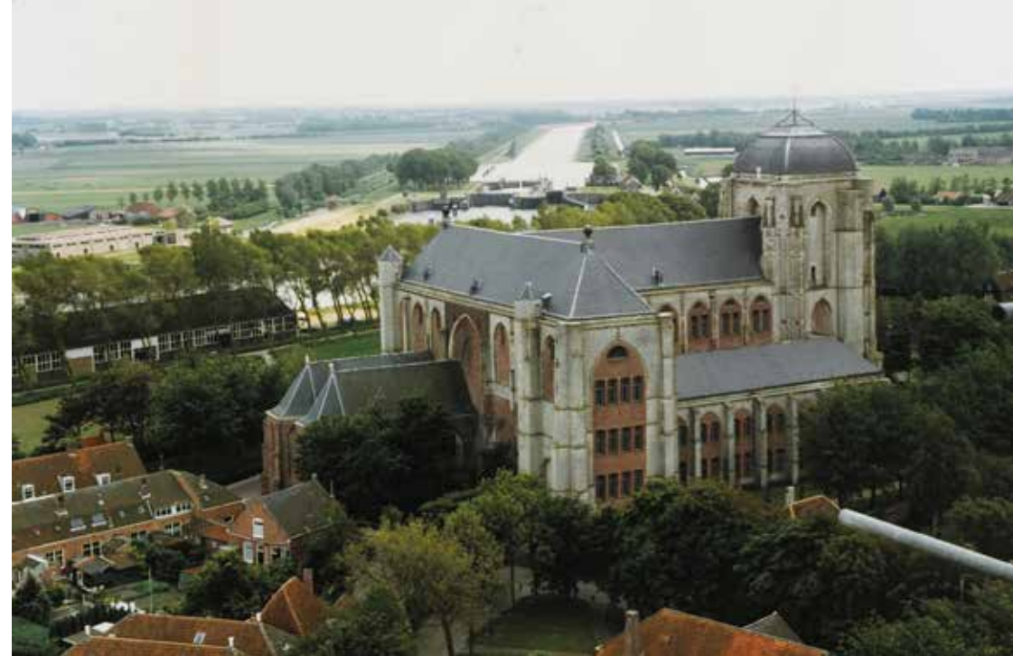
Afb. 1: De Grote Kerk in Veere. Een natuursteen frame, ingevuld met baksteenvlakken.
